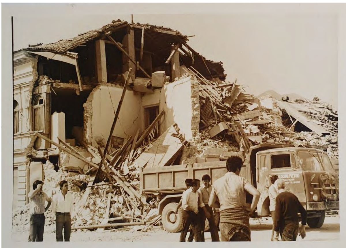
Immagine 9: Casa crollata a Maiano. Fotografia scattata nei giorni immediatamente successivi alla scossa del 6 maggio dal signor Claudio Floreani, nonno di una delle realizzatrici del progetto
