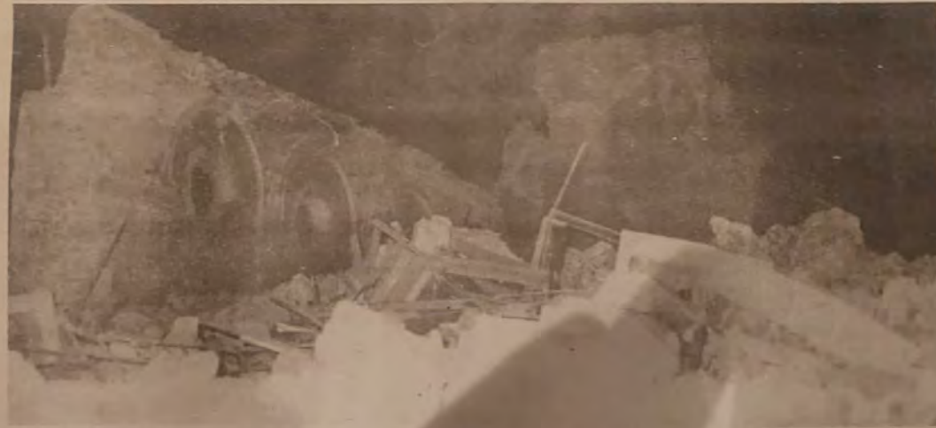
Catastrofico terremoto in Friuli, ieri sera, alle 21, una scossa sismica dell'ottavo grado della scala Mercalli ha devastato Maiano, Buia, Gemona, Osoppo, Magnano, Artegna, Colloredo, Tarcento, Forgaria, Vito d'Asio e molti altri paesi della pedemontana. Immediata e generosa è stata l'opera di soccorso per estrarre le vittime dalle macerie. A Udine e in tutti i centri della regione è stata trionfante una notte di paura e di veglia all'aperto. L'Alba ci mostra i segni dell'immane disastro. Nella foto, in alto, soccorritori all'opera a Maiano; in basso, ciò che resta della chiesa di Magnano. Il servizio alle pagine 2-3-4-6-7-17. Così e D'oggi
